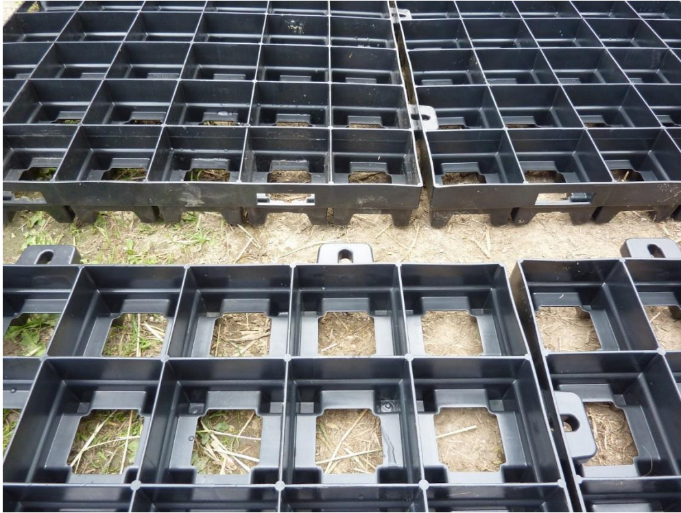
2. Befestigung der Platten mittels Keilverbindung
