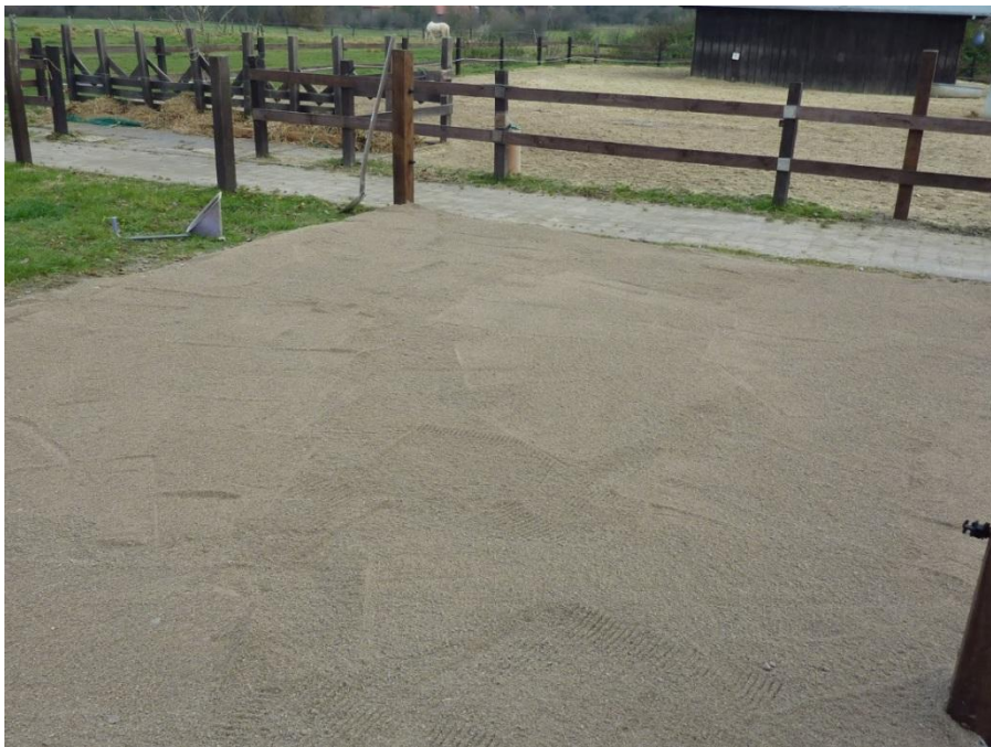
4. Anschließendes Auffüllen mit Sand
